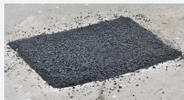
Parche de reparación temporal de asfalto en la calle y/o acera después del reemplazo de la línea de servicio.
